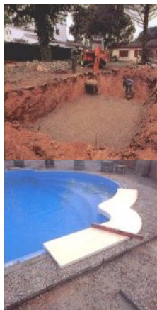
Proceso de montaje de una piscina prefabricada de poliéster (imágenes de Poliéster Porcuna S.L.)
