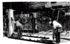
Ejecución de encofrado
